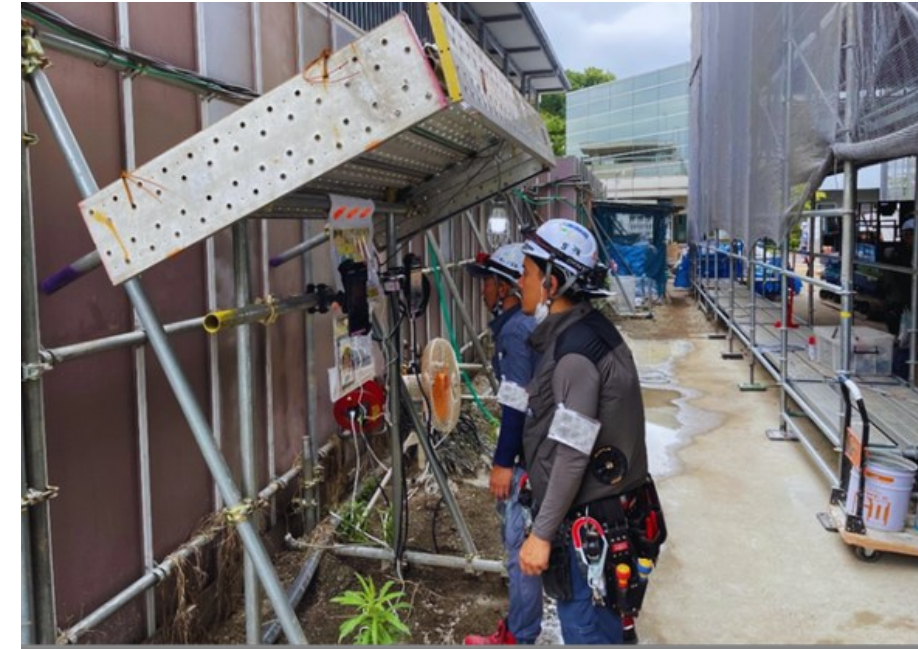
現場入場ドア付近
